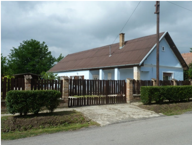
Oromfalas, tornácós lakóépület és díszített oromdeszkás lakóépület
