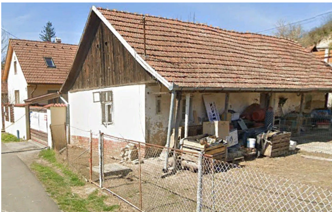
Csatlakozó, felújítás alatti épület
